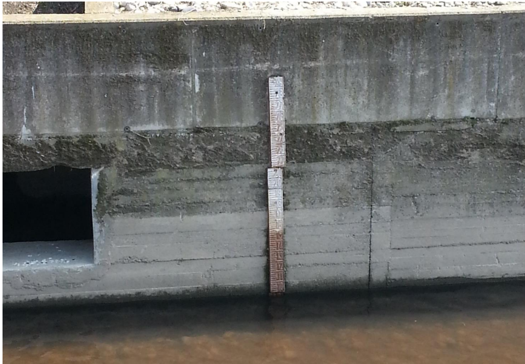
Figura 24 – Asta idrometrica su sinistra idrografica del torrente Seveso a monte dell’opera di presa del CSNO
