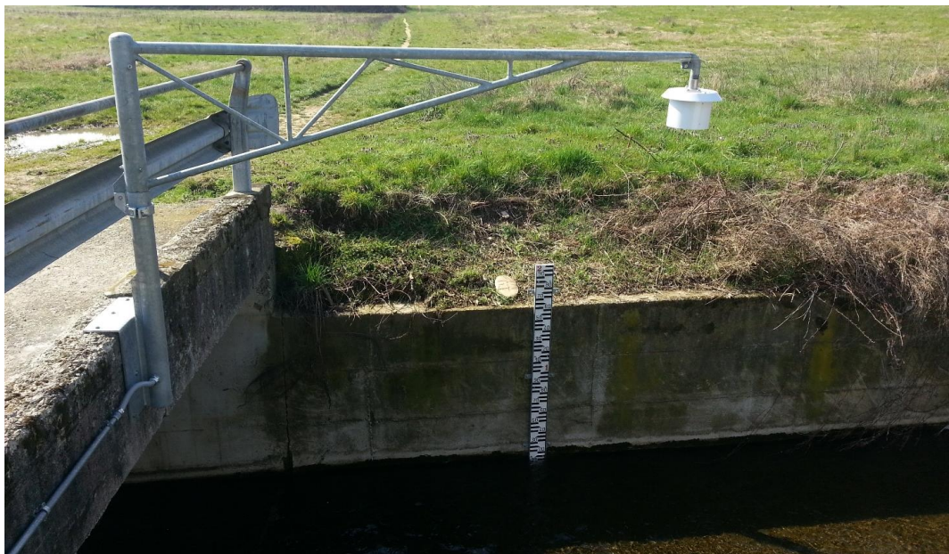
Figura 27 – Torrente Pudiga in corrispondenza della derivazione verso il CSNO. Focus su sensore di livello e asta idrometrica
